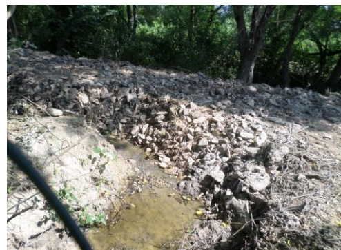
Canal de rejet
