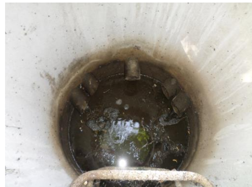
Regard de collecte - aval filtre à sable
