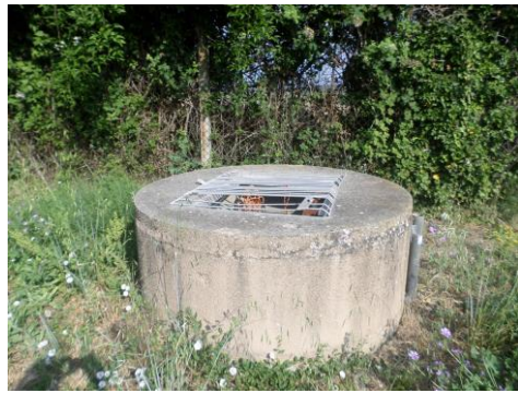
Ouvrage de recirculation des eaux claires
