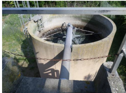
Alimentation depuis le décanteur-digesteur
