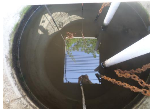
Ouvrage de recirculation des eaux claires
