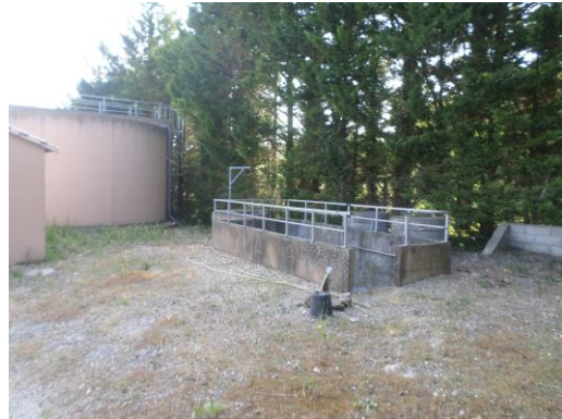
PR amont STEP – derrière le canal de prétraitement
