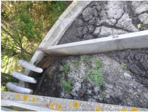
Alimentation par les conduites de refoulement + recirculation des boues depuis le clarificateur
