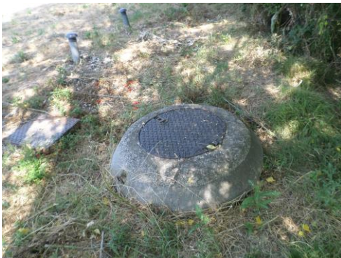
Regard de collecte - aval filtre à sable
