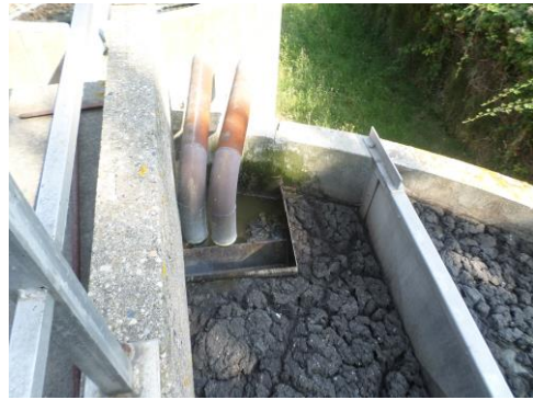
Arrivée des conduites de recirculation des eaux claires
