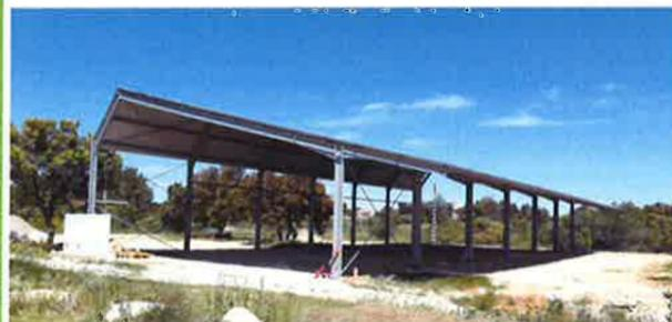
La structure du hangar communal ainsi que la pose des panneaux photovoltaïques sont terminés.
