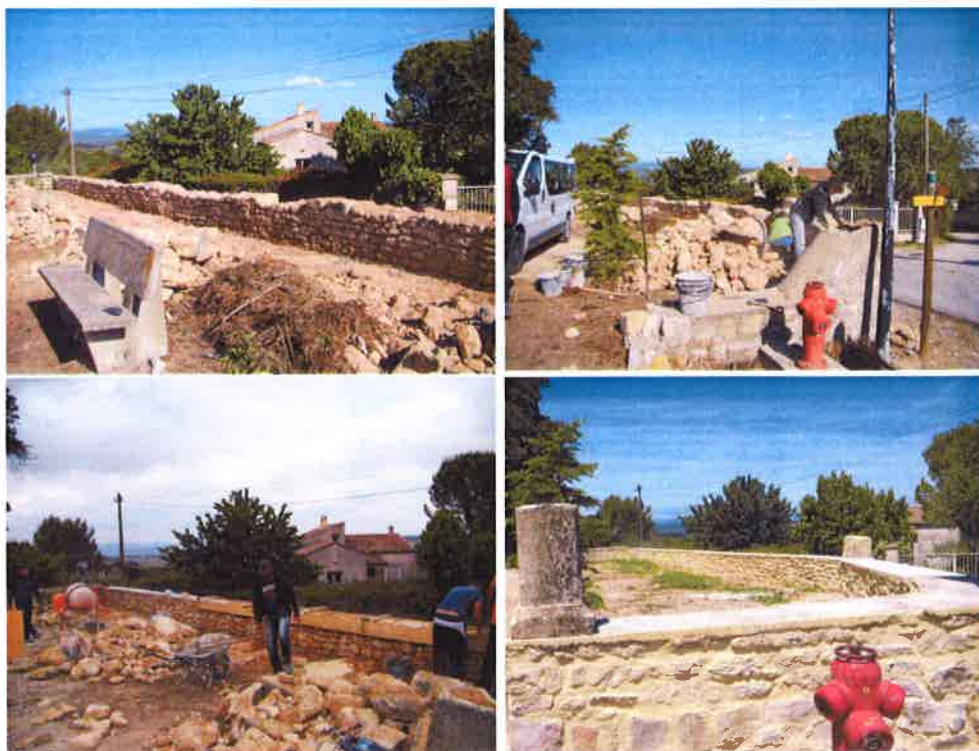
Première tranche de remise en état du mur, place du Cèdre par le chantier d'insertion
